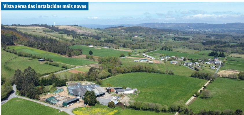
Vista aérea das instalacións máis novas
